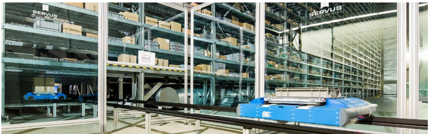
Servus Roboter ACR und automatisches Kleinteilelager (AKL)
