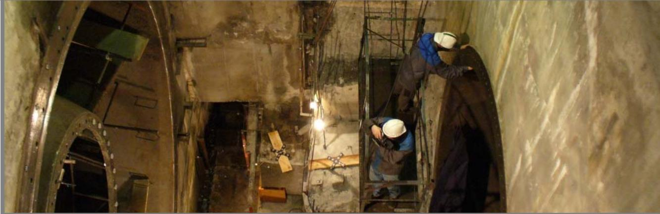
Der Sinn der Vermessung lag darin, die aktuellen Positionen der im Bau integrierten Flansche zu ermitteln, um dort vorhandene Abweichungen bei der Fertigung der Neuteile berücksichtigen zu können.
